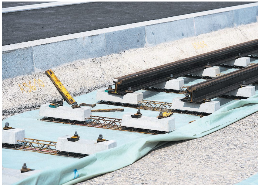
Die erste Etappe der Limmattalbahn ist im Bau.
